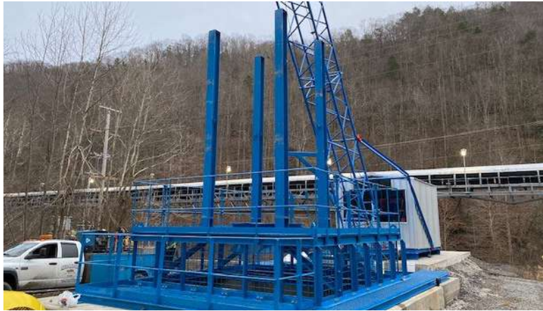
Cápsula de escape en proceso de instalación
