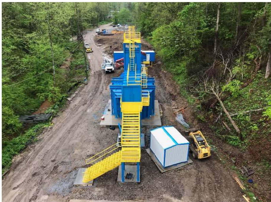
IMAGEN 12. CÁPSULA DE ESCAPE EN PROCESO DE INSTALACIÓN
