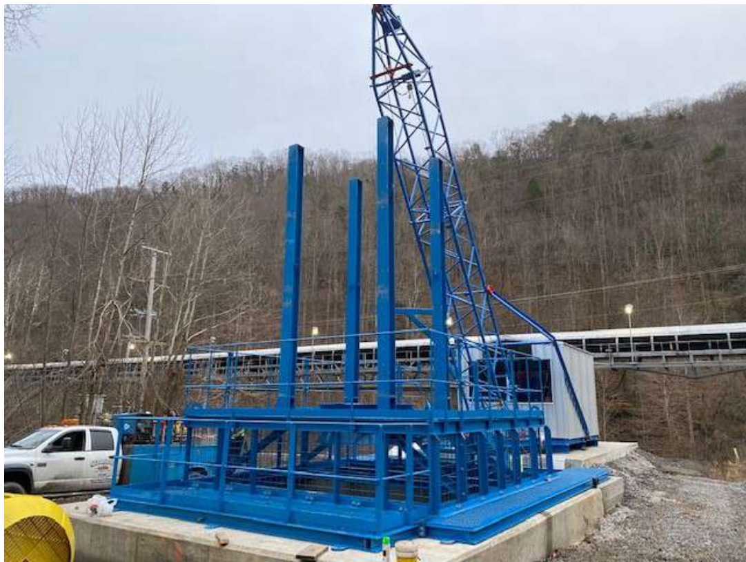
IMAGEN 9. CÁPSULA DE ESCAPE EN PROCESO DE INSTALACIÓN
