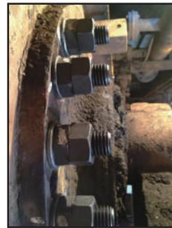
Instalado con tuercas HARDLOCK
