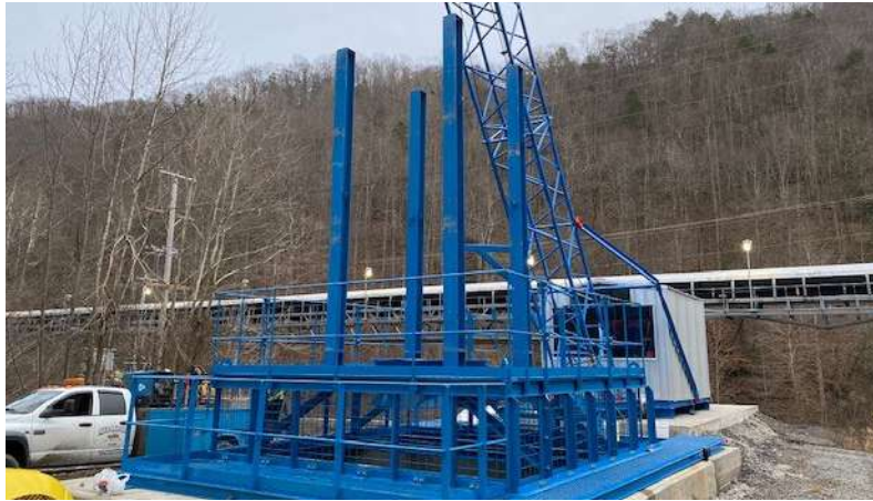
Cápsula de escape en proceso de instalación
